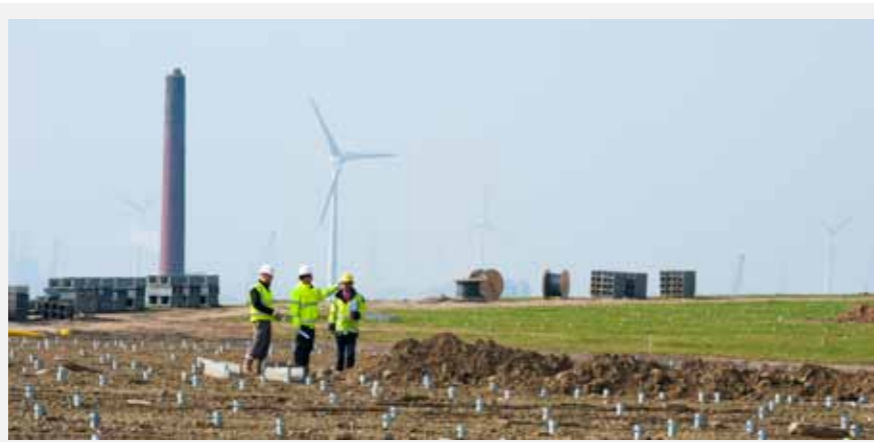
Een deel van de site wordt ontwikkeld als bedrijventerrein.
