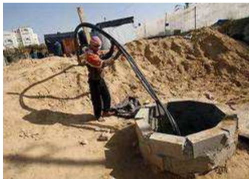
Er wordt onder meer brandstof via de tunnels gesmokkeld. © unknown.
