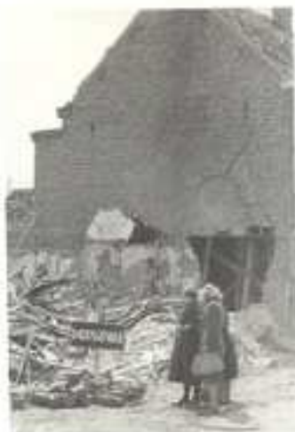
Hoek Lindestraat - Sterrestraat met het bord DOODSGEVAAR, wegens instortingsgevaar van het aanpalende huis of het risico op blindgangers (niet ontplote bommen).
